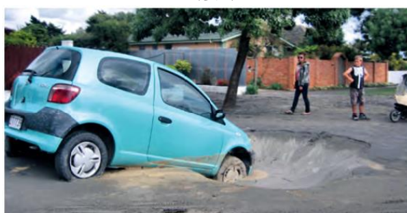
شکل ۲۱: چاله ایجاد شده به خاطر روانگرایی خاک بر اثر زلزله
