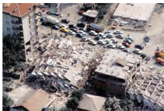
شکل ۱۷: تخریب کامل ساختمان بر اثر زلزله (ترکیه)
