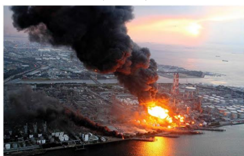
شکل ۲۲: آتش‌سوزی ایجاد شده در تاسیسات نفتی بر اثر زلزله
