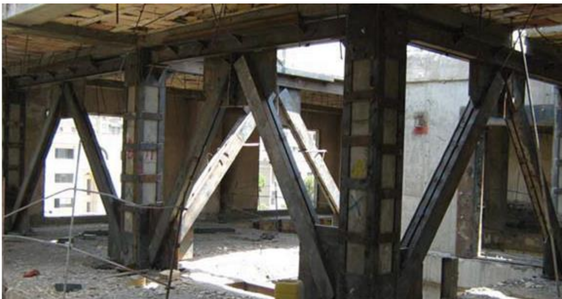
شکل ۲۹: نسل اول مقاوم سازی، اجرای بادبند
