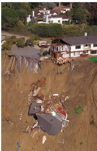
شکل ۲۰: تخریب حاصل از رانش زمین بر اثر زلزله (کالیفرنیا)
