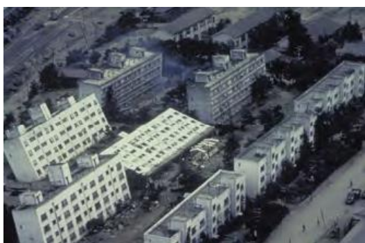
شکل ۱۸: واژگونی ساختمان بر اثر روان‌گرایی خاک (تایوان)
