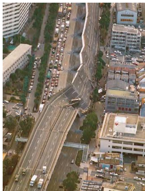
شکل ۱۹: تخریب پل طبقاتی بر اثر شکست ستون‌ها (ژاپن)
